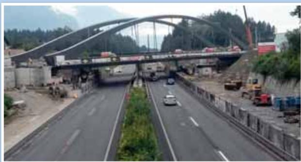
Seit Anfang September rollt die Eisenbahn über die neue Autobahnbrücke, die neben der alten Brücke errichtet wurde und dann seitlich eingeschoben wurde. Hier im Bild die Situation wenige Tage vor dem Beginn des Einschubens. Noch bis November sind Arbeiten im Umfeld der Brücke geplant.
