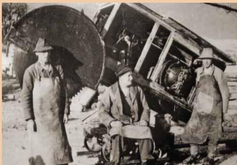
**Ländarbeiter an der Kappsäge.** Mit dieser Säge wurden die Baumstämme in ihre entsprechende Länge gebracht. Das Sägeblatt hatte einen Durchmesser von einem Meter.
